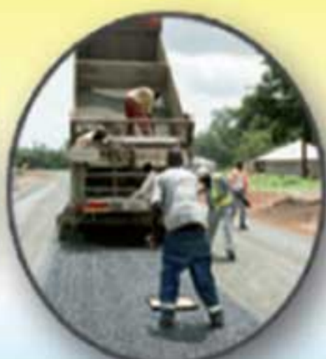
Aménagement de chaussées
